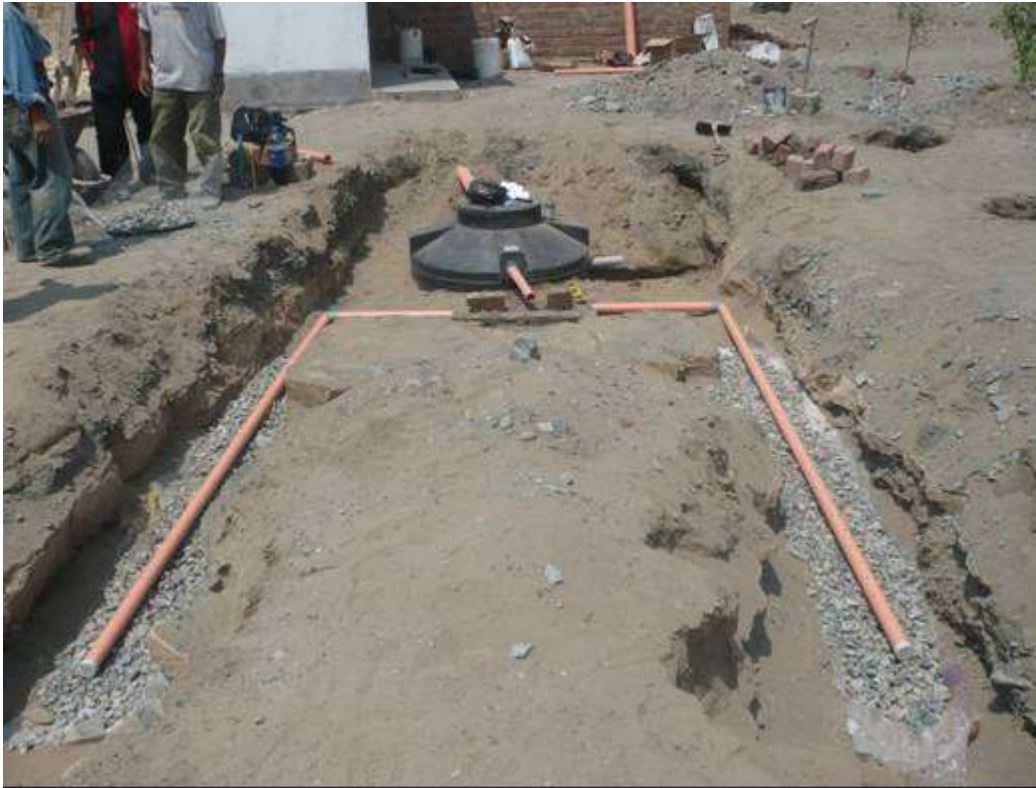
Vista de las tuberías en la zanja de infiltración.
