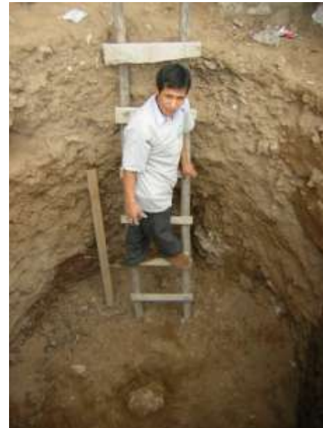
Biodigestor de 3,000 l.
