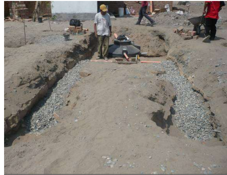
➤ Zanjas de infiltración.
